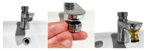
Método 2: Retire el adaptador del grifo. Une la parte A con la parte B girando las piezas entre sí. Enróscalas en el grifo.
